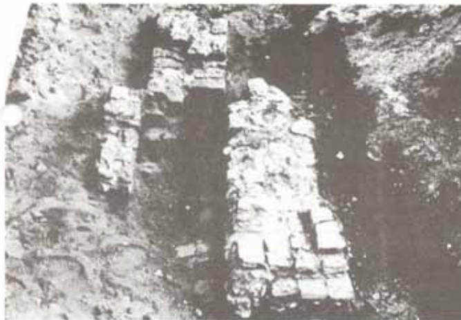
15 août 1983: Découverte à l'Ancienne-Lorette des vestiges du mur-est de la chapelle bâtie en 1674, sous la direction du Père Chaumonot. À l'époque, un foyer se trouvait au centre de ce mur. Sur le manteau de la cheminée, on avait placé la statue de Notre-Dame de Lorette reçue en 1674.
